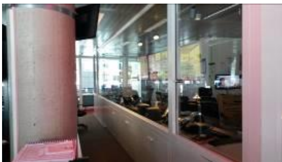
Figure 5 : Cloison de séparation à déposer
